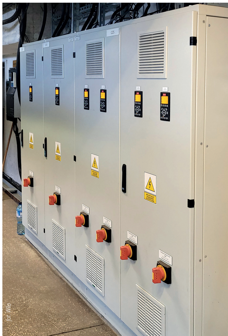
SZAFY ZASILAJĄCE I STERUJĄCE pompami w ECO Malbork
